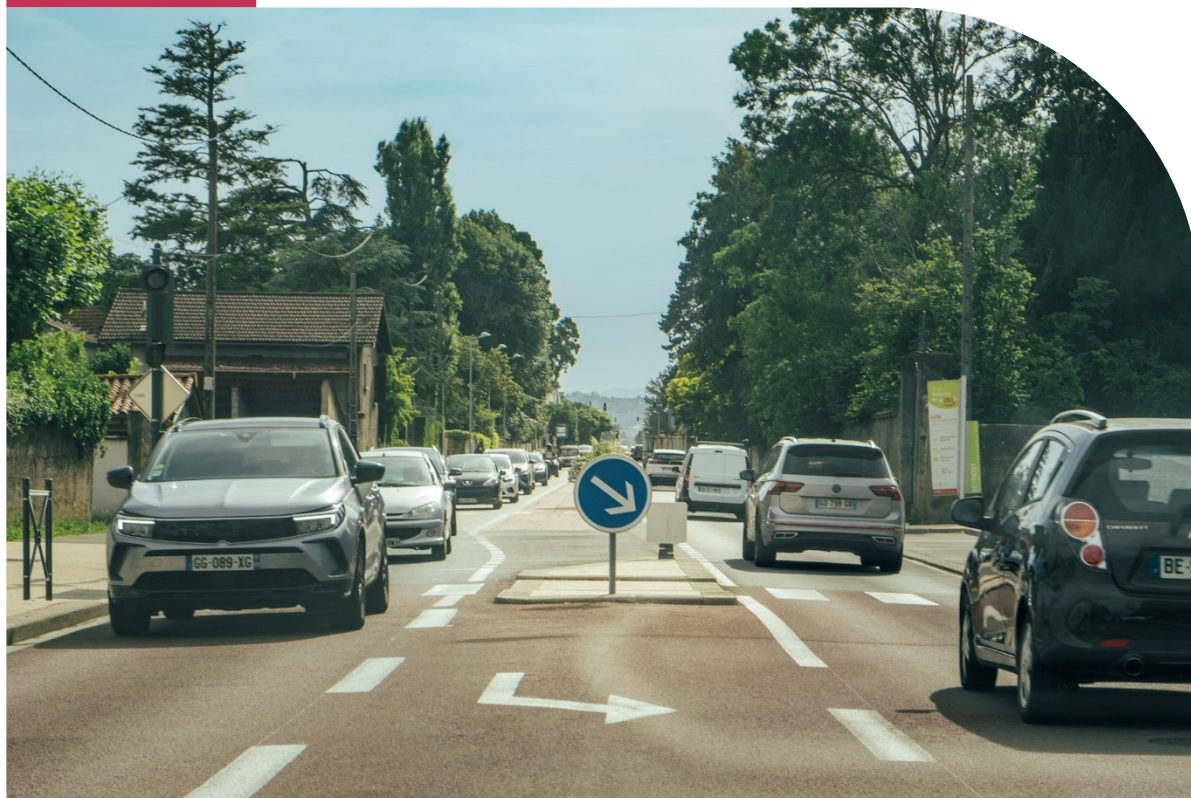
Route de Genève (traversée de Beynost) voit passer plus de 13000 voitures quotidiennement.
