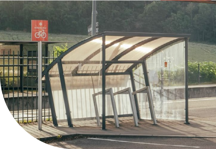
Arceaux vélos Gare des Échets.
