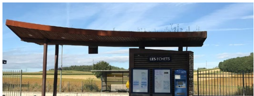
La signalétique SNCF.
